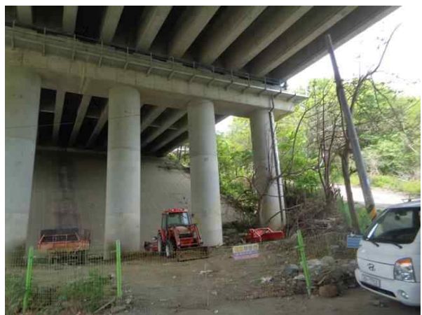
금남IC R-A교(상) 하부구조(교각) 전경
