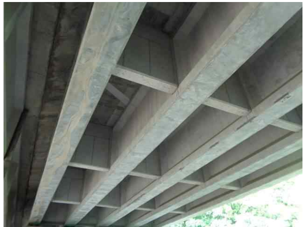
사능1교(상) 상부구조 전경
