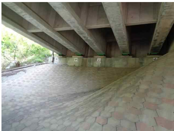
사능1교(상) 하부구조(교대) 전경
