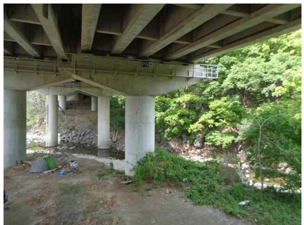
사능1교(상) 하부구조(교각) 전경
