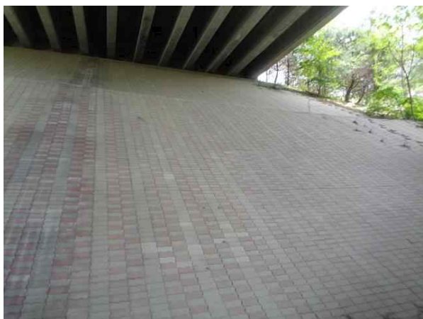
금남IC R-A교(상) 하부구조(교대) 전경
