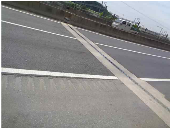
사능1교(상) 신축이음 전경
