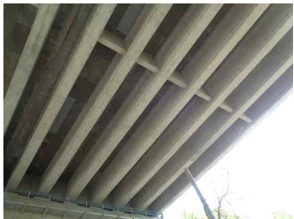
금남IC R-A교(상) 상부구조 전경
